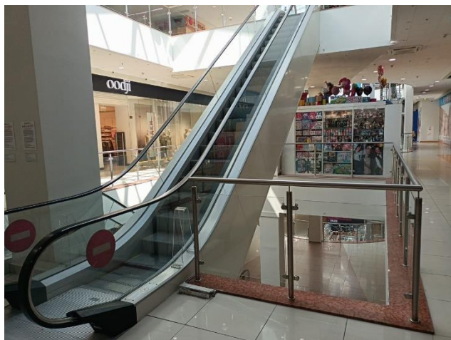
Фото 15. Состояние помещений 3 этажа
