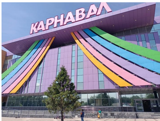
Фото 1. Внешний вид здания
