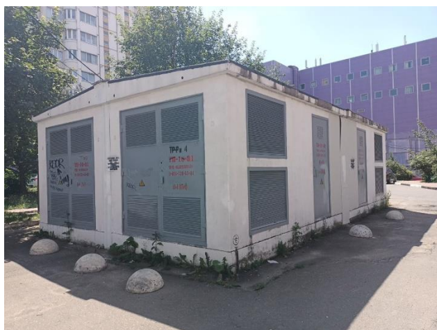
Фото 34. Здание трансформаторной подстанции
