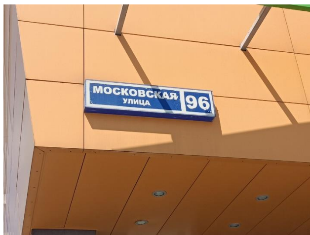
Фото 2. Внешний вид здания
