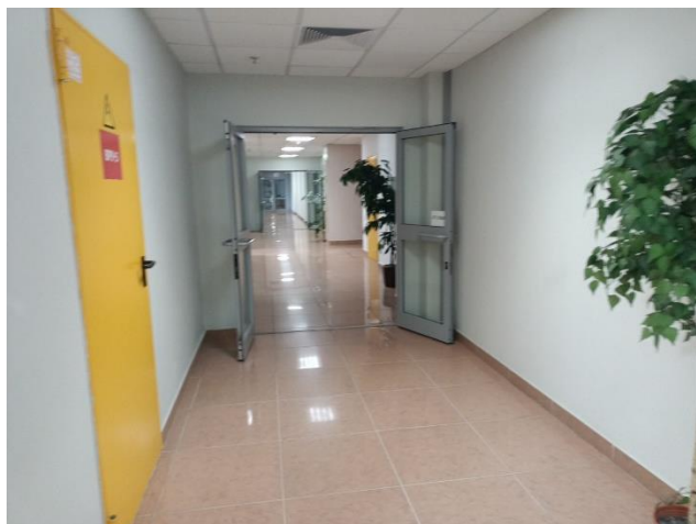
Фото 24. Состояние помещений 5 этажа
