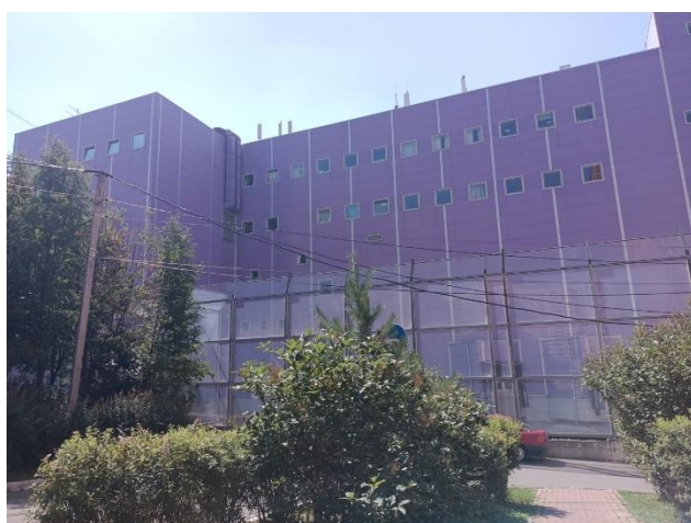
Фото 3. Внешний вид здания
