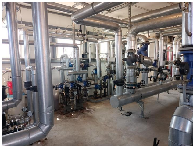
Фото 27. Состояние помещений 6 этажа
