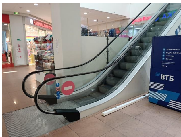
Фото 10. Состояние помещений этажа -1
