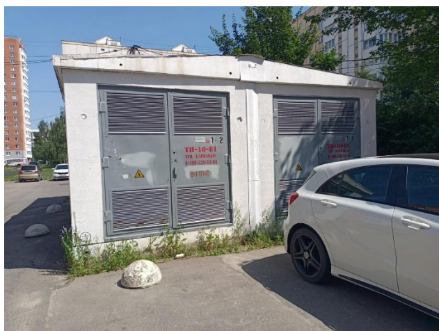
Фото 33. Здание трансформаторной подстанции
